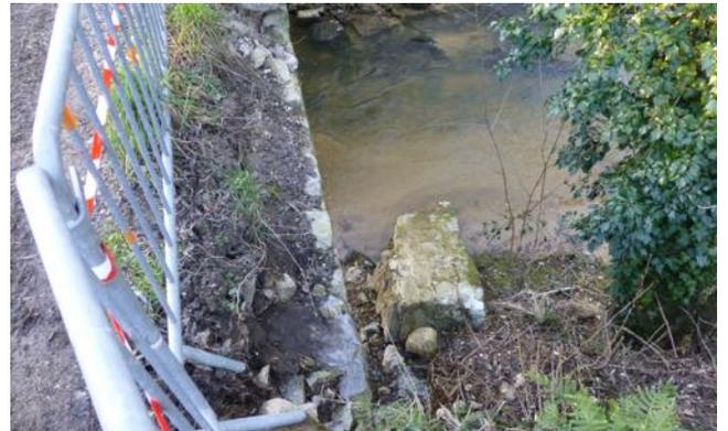
■ Une partie du parapet gît au fond du Garon, arraché par un véhicule de grand gabarit. Photo Michel Dumont
