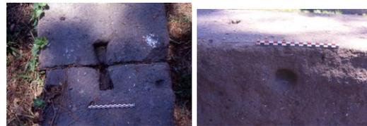
Blocs de tuf : à gauche, négatif d'une double queue d'aronde rendant solidaire 2 blocs ; à droite, trou d'une tenon de levage (Ostie)
