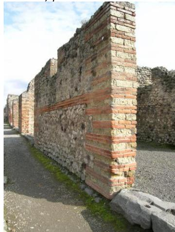
Thermes Centraux : chaînage d'angle en opus mixtum et assises de réglage de briques dans un appareil d'opus incertum.
