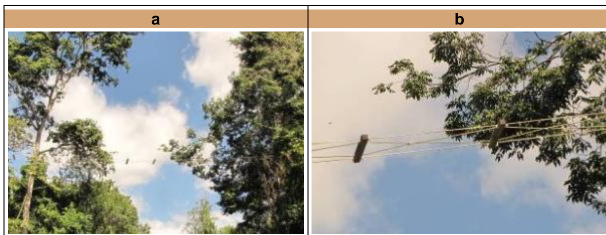
Fotografia 554. a) Passagem aérea de fauna instalada na região leste da FLONA; b) Detalhe da passagem aérea de fauna instalada na FLONA
