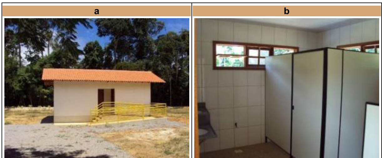
Fotografia 15. a) Vista exterior dos sanitários; b) Visão interna dos sanitários
