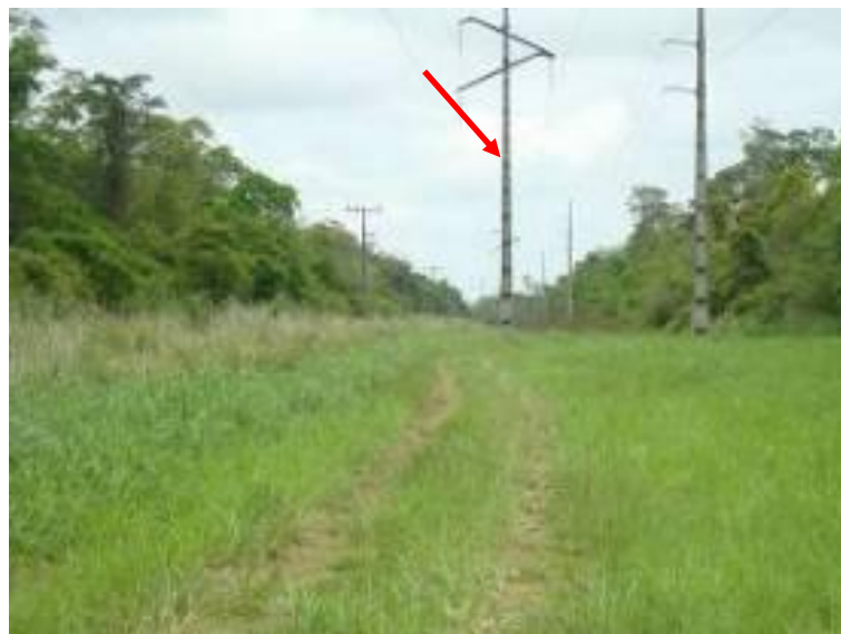
Figura 20. Linha de transmissão dentro da área da FLONA, instalada sobre topo de colina
