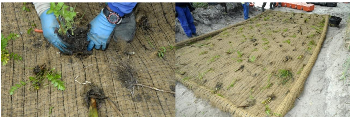
Figura 41. Entretejido de rizomas con brotes en malla de coco y plataforma antes de su colocación.
