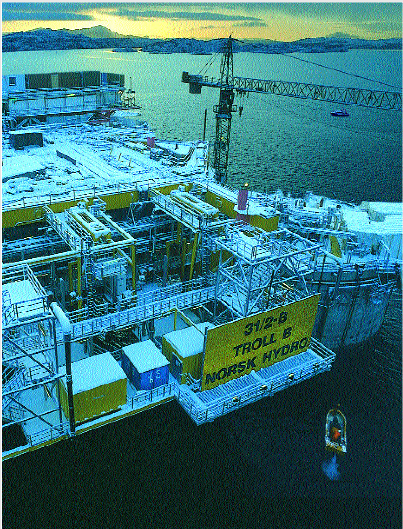
Hydro er operatør for utbygging og drift av Troll Olje, som skal være i produksjon mot slutten av 1995. Det omfattende prosjektet for utvinning av de tynne oljelagene i Trollfeltet passerte en milepel i februar 1995, da den 9.000 tonn tunge deksrammen til plattformen ble koblet sammen med betongunderstellet.
