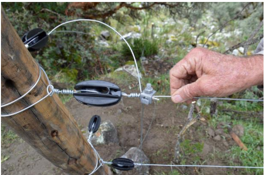
Foto 05: Amarre de aisladores esquineros en postes esquineros, instalación de cerco eléctrico 02/09/2016.
