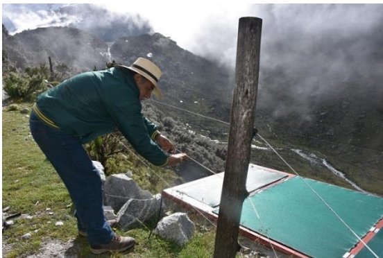
Foto 40: Realizando la prueba de funcionamiento del cerco eléctrico, abril-2017, por el asesor de la investigación: Ing. Juan Roque González.
