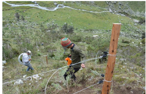
Foto 06: Tendido de alambres tres líneas, instalación de cerco eléctrico 02/09/2016.
