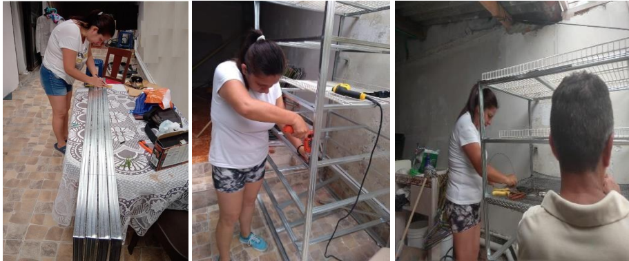
Diseño y corte de la estructura
