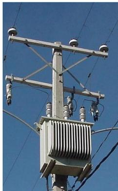
FIGURA 9. TRANSFORMADOR DE DISTRIBUCION
