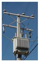
FIGURA 9. TRANSFORMADOR DE DISTRIBUCION
