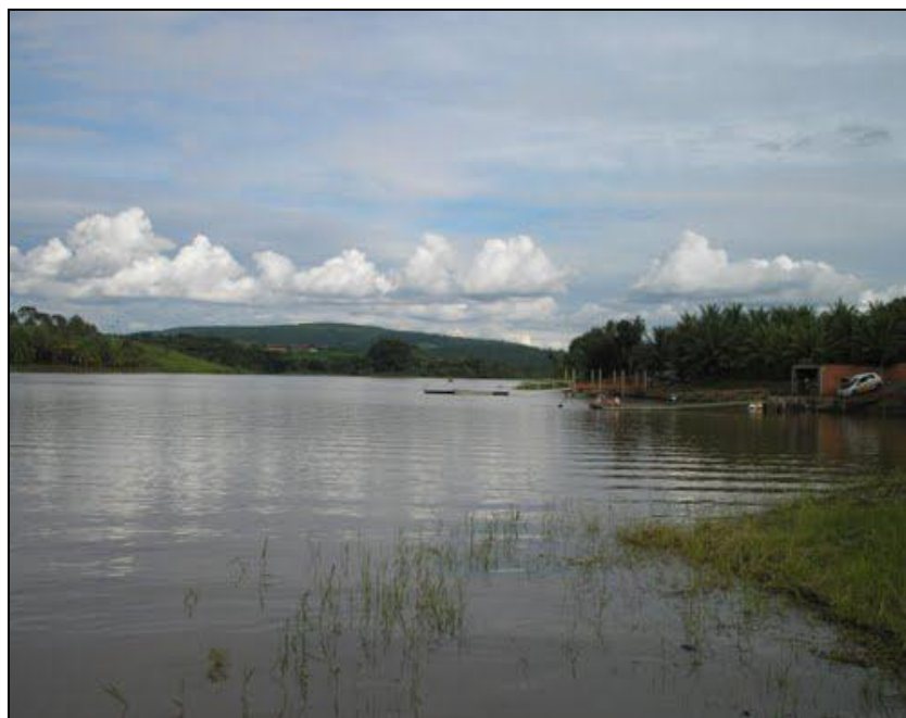
Figura 6.7 – Lago Reservatório Barragem 1 (Foto: Fernando Rios Porto)
