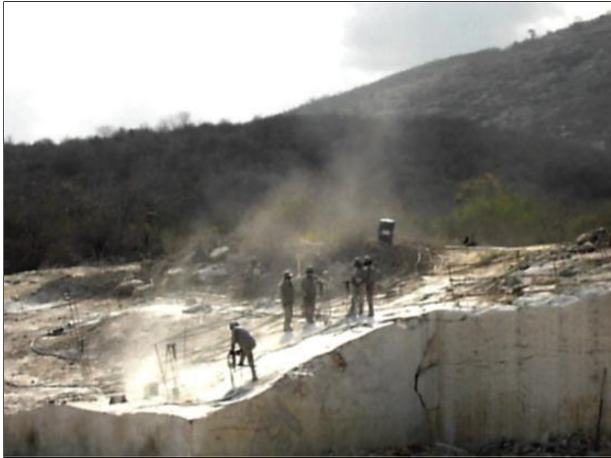
Figura 3.10 - Aplicação de técnicas de corte cíclicas com o uso de marteletes e explosivos para a separação dos blocos na JQ3
