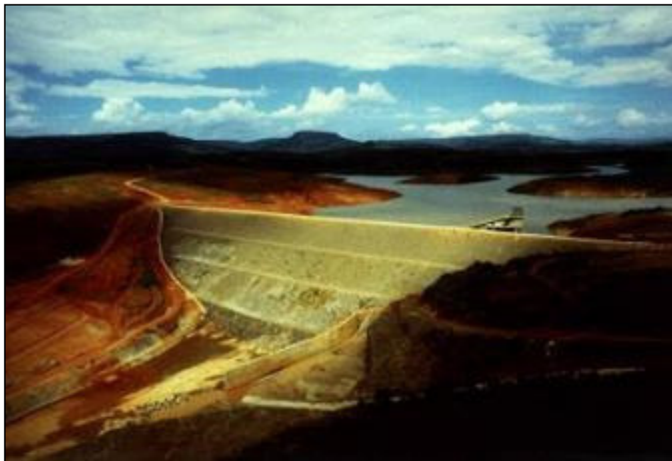
Figura 8.8 – Barragem do Calhauzinho
