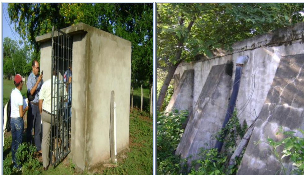
Foto. 3-6. Estación de bombeo y tanque de abastecimiento del Pozo El Limonar. Fuente: POMCA Río Chiriamo
