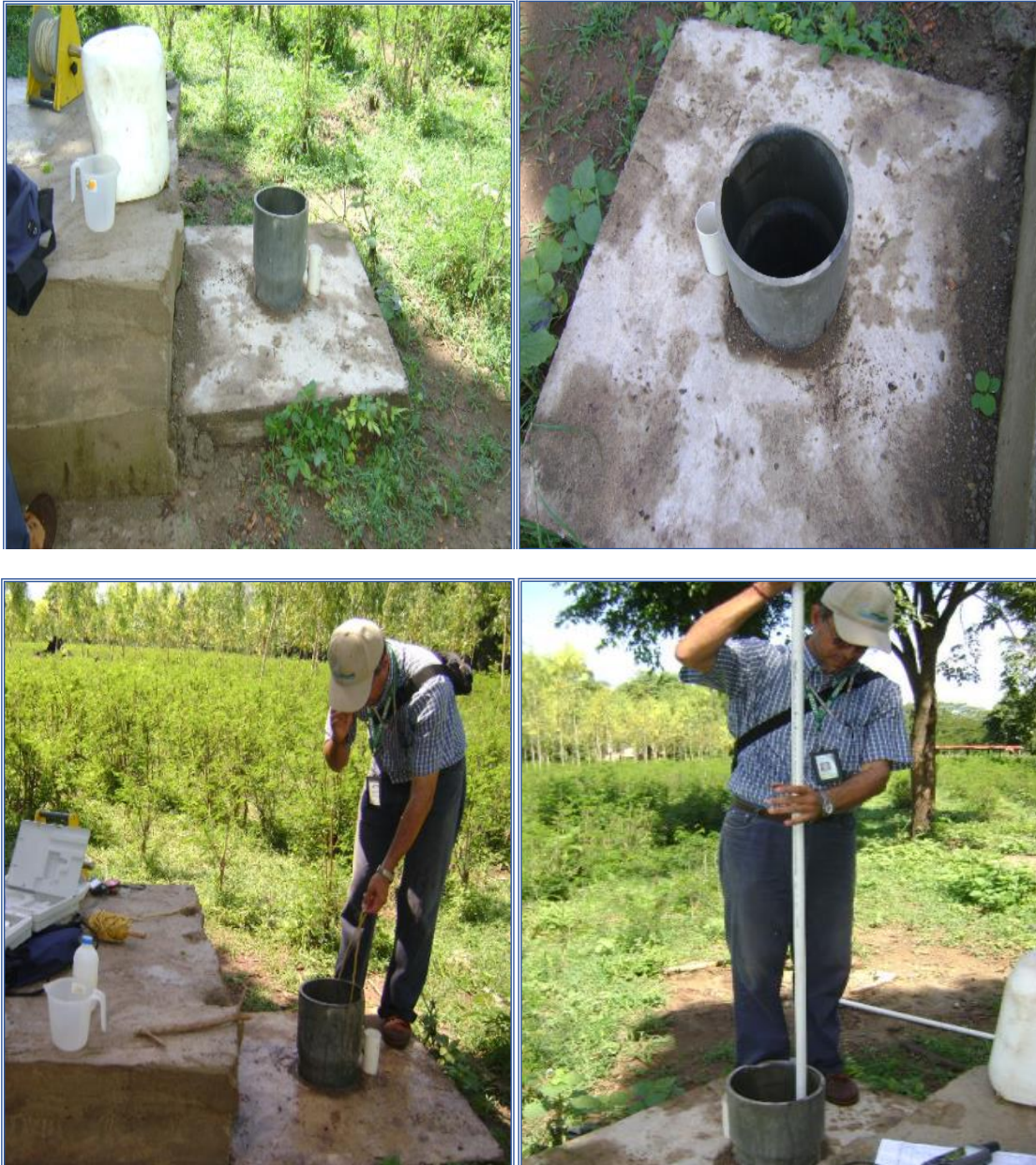
Foto. 3-8. Boca del Pozo El Trabajo. Fuera de servicio.
