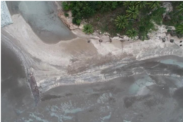
Kondisi Pantai Ndalir yang mengalami Abrasi akibat Penambangan Pasir
