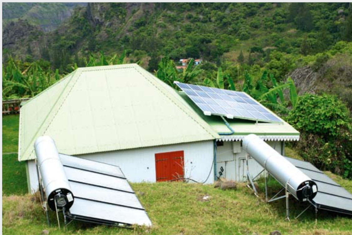
Figure 164 Installation de panneaux photovoltaïques à l'îlet de Grand-Place, cirque de Mafate
