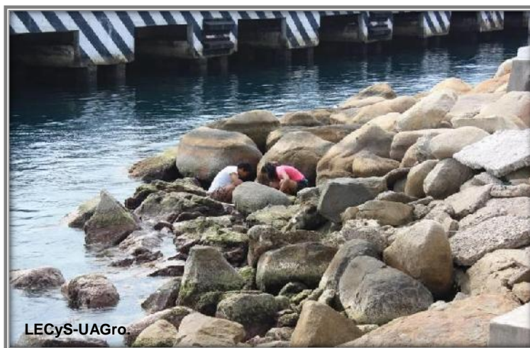
Figura 17. Acercamientos al sustrato de Muelle.
