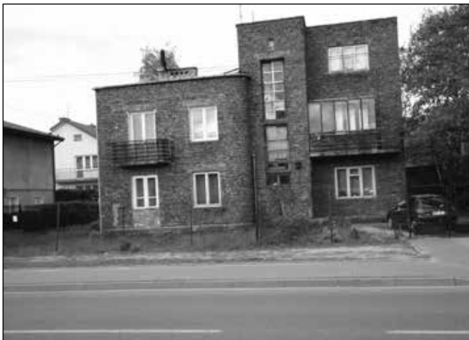
Stary dom ul. Piłsudskiego 26. Na parterze widoczne miejsce po balkonie
