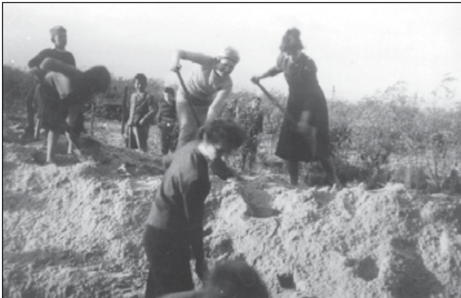
Mieszkańcy Pustelnika przy robotach ziemnych 1960 rok
