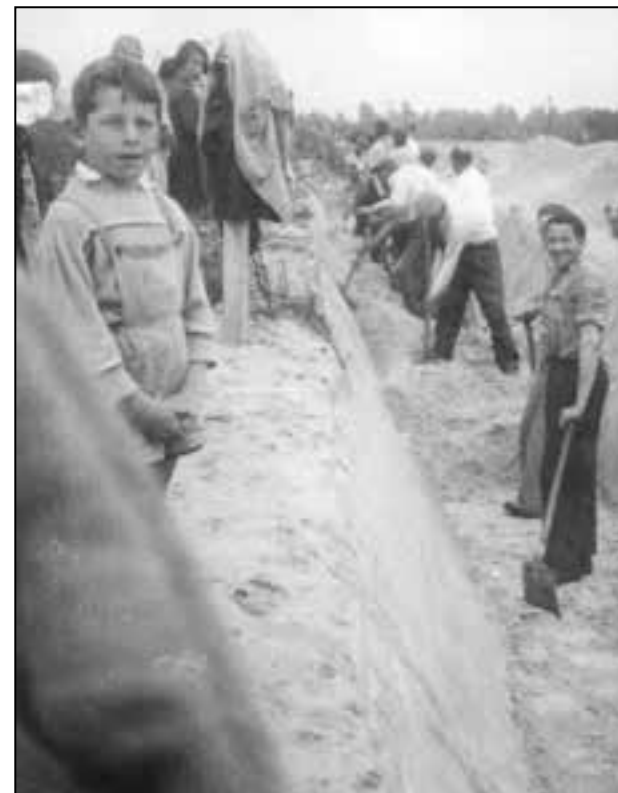
Mieszkańcy Pustelnika przy wykopach pod fundamenty Tysiąclatki 1960 rok
