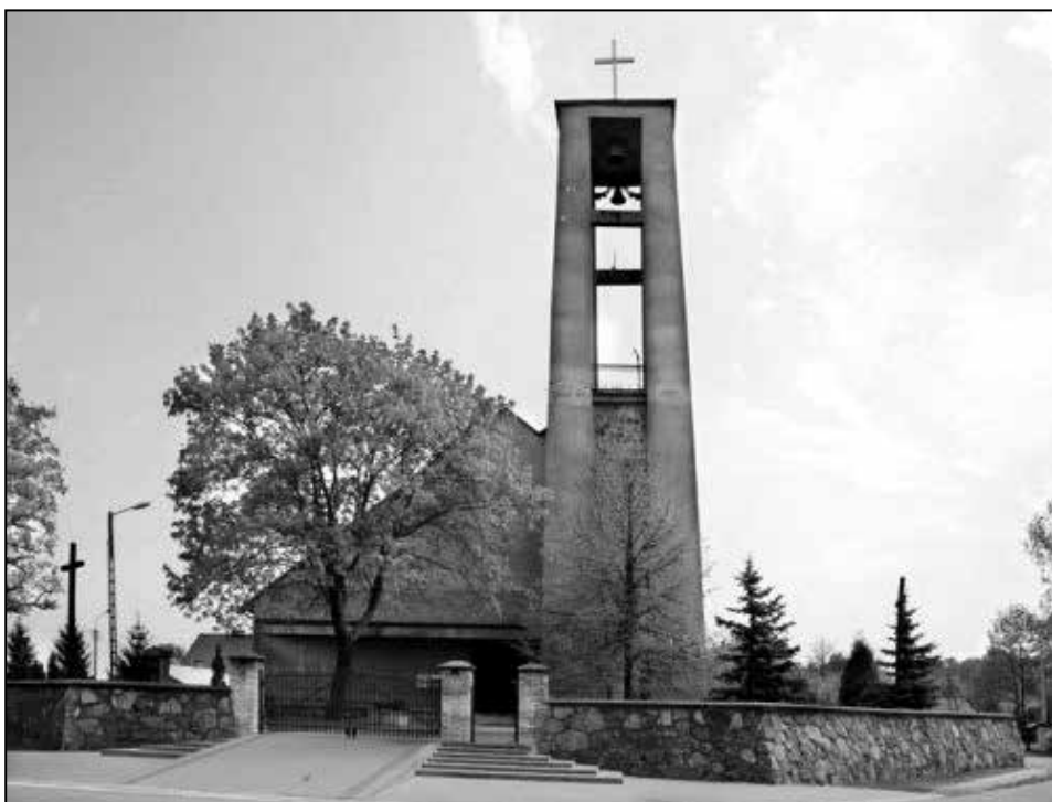
Wejście do kościoła w Pustelniku
