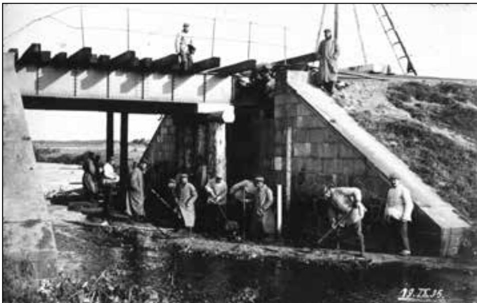
Odbudowa mostu kolejowego na Rządzy koło Klembowa, 19 września 1915 r., nr 91
