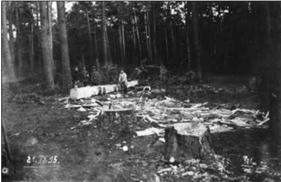
Wycinka drzew na odbudowę mostu koło Jasienicy, 21 września 1915 r., nr 101
