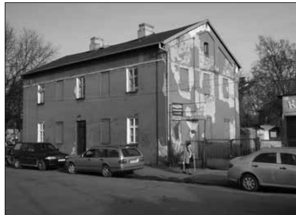
Budynek kolejowy z 1883 roku ul. Legionów widok od strony torów
