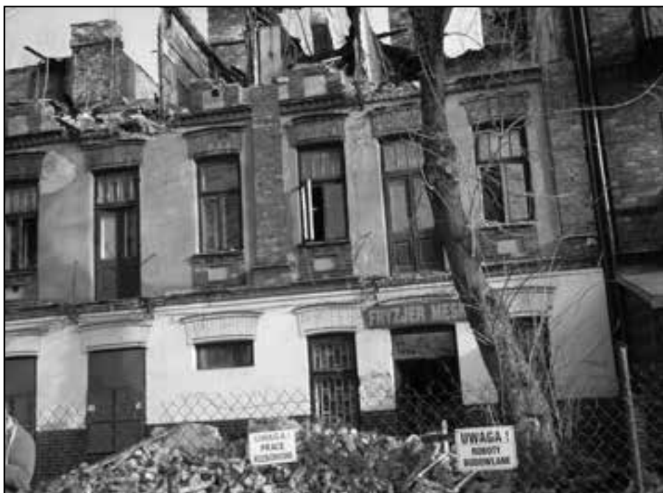
Kamienica w której była cukiernia pp. Gilskich (została wyburzona w 2016 r.)
