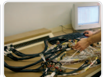
→ Contrôle électrique d'un harnais → Electrical inspection of a harness
