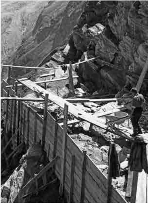
*Der Bau der Fundamente des Kuppenübergangs für die Materialseilbahn auf der Hohen Kirche (zwischen Talstation in Innervals und dem Stollen unterhalb der Alpeiner Scharte) war im steilen Gelände besonders schwierig und gefährlich*
