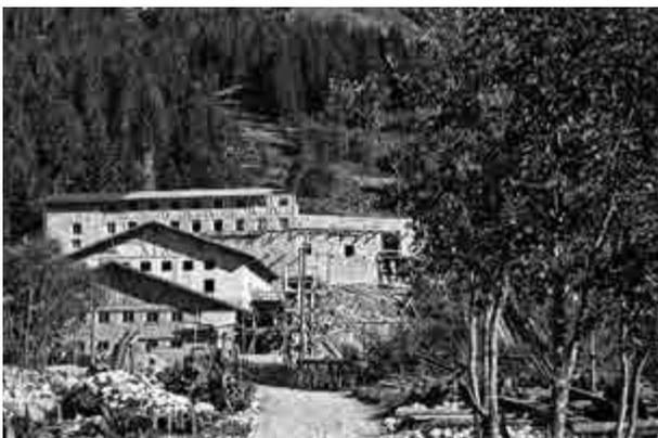
*Baustelle am Fuß der Hohen Kirche in Innervals. Dieser Gebäudekomplex sollte als Talstation der Materialseilbahn, als Umspannwerk für die Starkstromleitung auf die Alpeiner Scharte und als Flotationsanlage für die Molybdänaufbereitung dienen*
