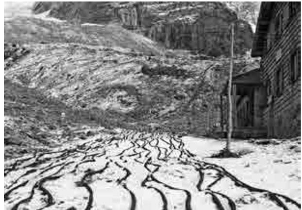
*Da die anfänglich eingesetzten Dieselmotoren in 2900 m Höhe nicht funktionierten plante man 1943 den Stollen zu »elektrifizieren«. Eine Erdleitung wurde vom Umspannwerk Innervals in einem Stück auf die Scharte verlegt. Hunderte Träger kamen dabei zum Einsatz. Vor der Geraer Hütte wurde das Kabel zwischengelagert*
