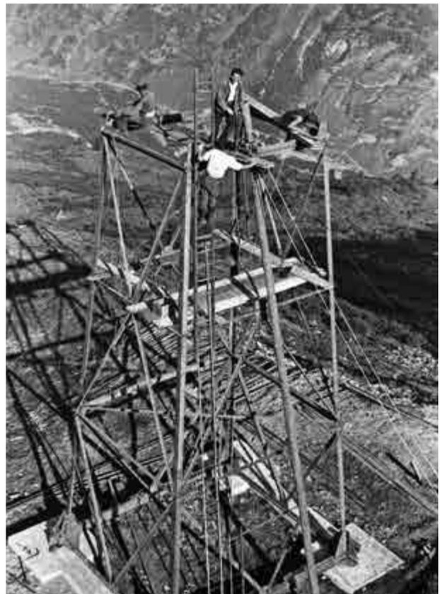
*Die für 50 Tonnen Tagesleistung ausgelegte 6 km lange Materialseilbahn von der Alpeiner Scharte über die Hohe Kirche hinunter zur Molybdän-Aufbereitungsanlage in Innervals führende Materialseilbahn musste kleinteiligst geplant werden, da für die Montage nur insgesamt sechs Hilfsseilzüge mit einer Maximallast von 500 kg zur Verfügung standen. Insgesamt wurden 22 Stützen und ein gigantischer Kuppenübergang auf der Hohen Kirche errichtet*
