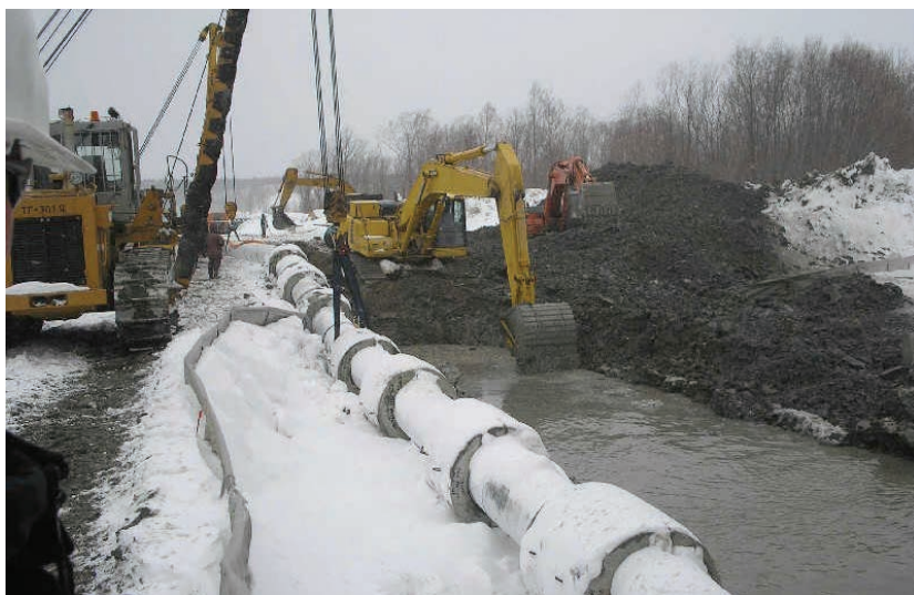
Рис. 1. – Река Ай – строительство перехода нефтегазопровода, рытье траншеи, 2006 год (источник: официальный сайт «Сахалин Энерджи», www.sakhalinenergy.com )
