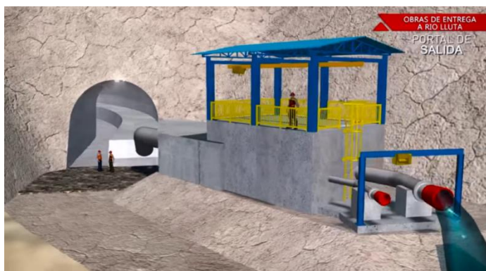
Figura 1.23. Portal de Salida del embalse Chironta. Fuente: Dirección de Obras Hidráulicas, Ministerio de Obras Públicas.
