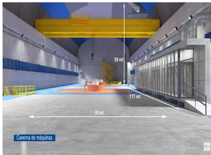
Figura 1.17. Caverna de máquinas, Angostura. Fuente: Página web de Colbún S.A.
