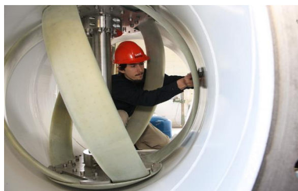
Figura 1.5. Instalación de una turbina LucidPipe. Fuente: Website de LucidEnergy.
