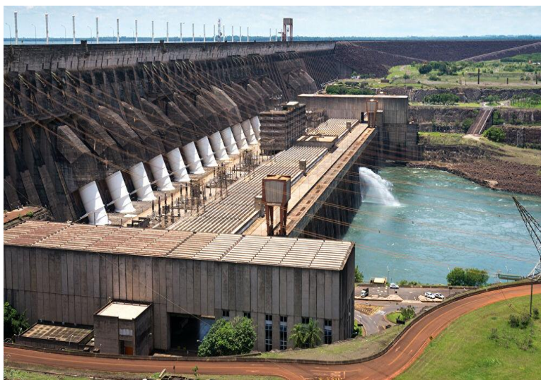
Figura 1.14. Hidroeléctrica Itaipú, Brasil. Fuente: Revista digital “Sputnik”.
