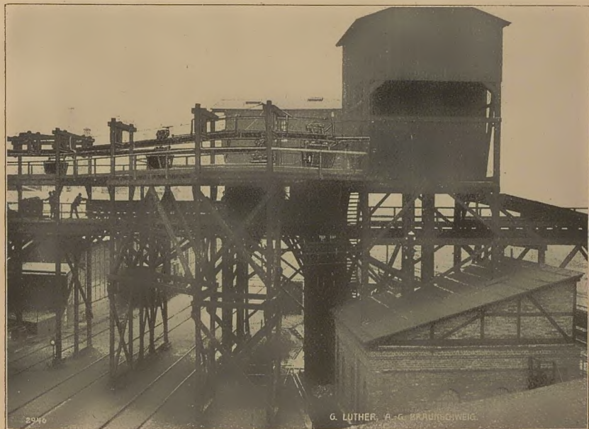
Figur 14. Elektrohängebahnanlage zum Befördern von Salz.
