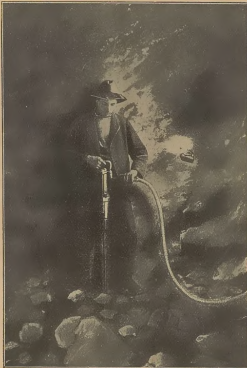
Fig. 1. Bohrhammer mit Selbstätigem Umsatz.
