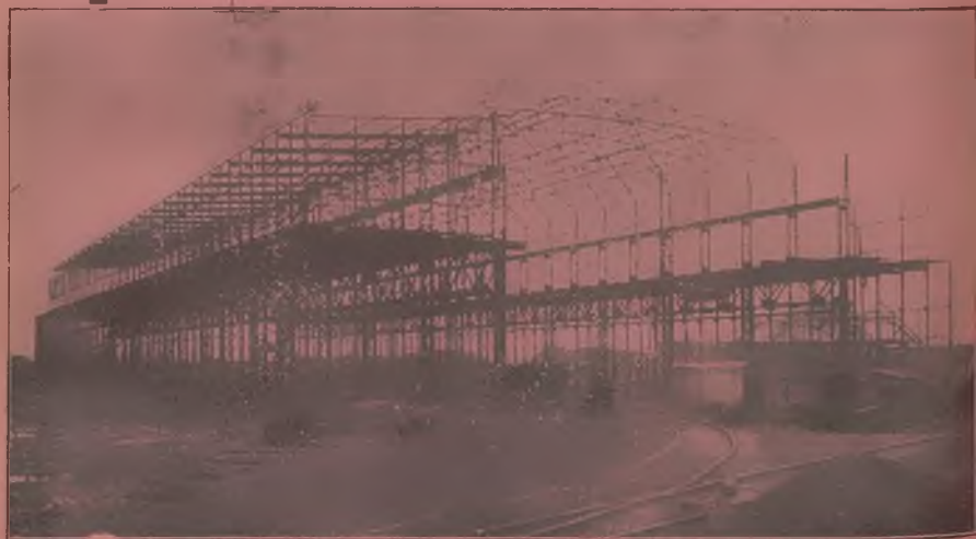
Stahlwerk Thyssen, Hagendingen, ca. 1000 Tons, Mechn. Werkstätte.
