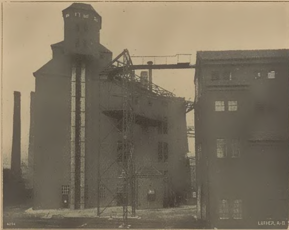
Figur 6. Elektrohängebahn im Gaswerk Hagen.
