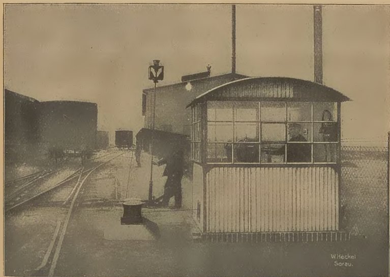
Abbildung IV. Rangier-Anlage mit 2 Winden, geliefert für eine Cellulose-Fabrik.
