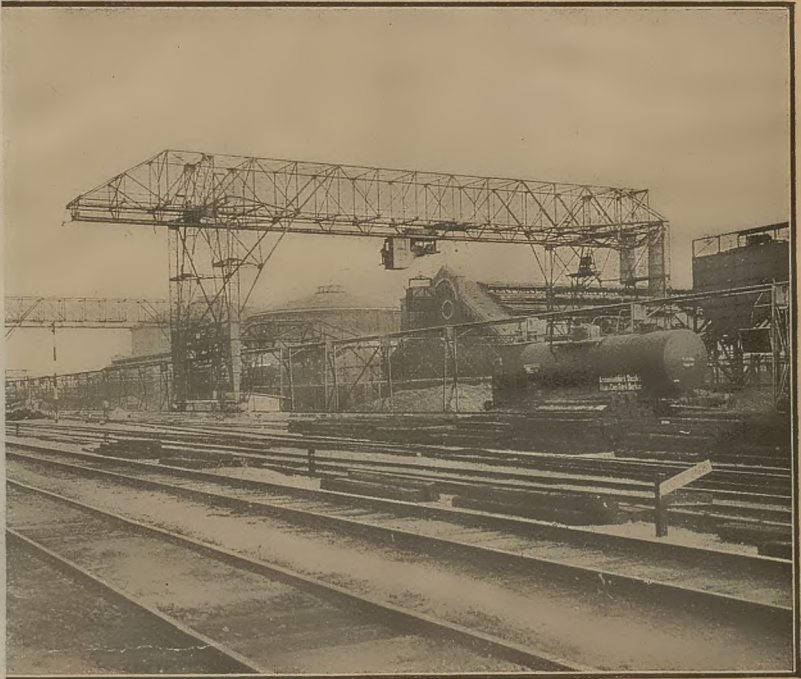
Erhohungsbrücken nebst Hängebahnanlage in Düsseldorf; ausgeführt von J. Pohlig Aktiengesellschaft, Köln.
