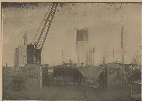
Figur 4. Selbsttätige Wagen bei der Hedwigshütte Stettin. (17 selbsttätige Wagen Bauart Schenck in Betrieb.)
