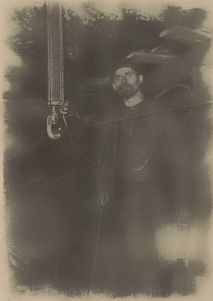
Fig. 6. Zylinder-Hebezeug in der Grube.
