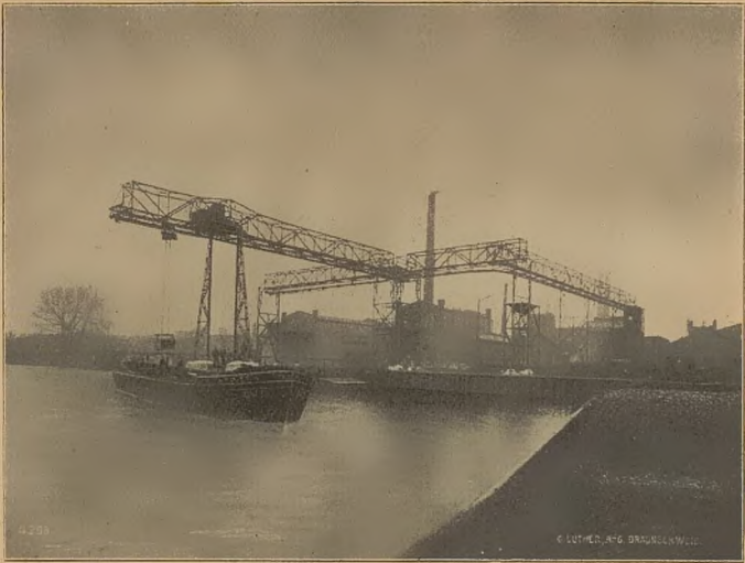
Figur 15. Elektrohängebahnanlage zum Transport von Kohle und Salpeter.
