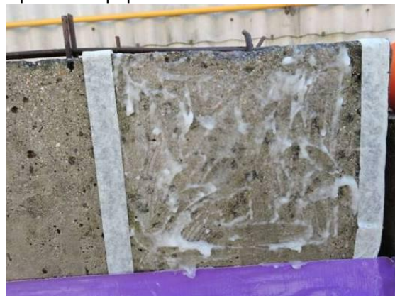
Limpieza con papeta AB57 modificada con biocida.
