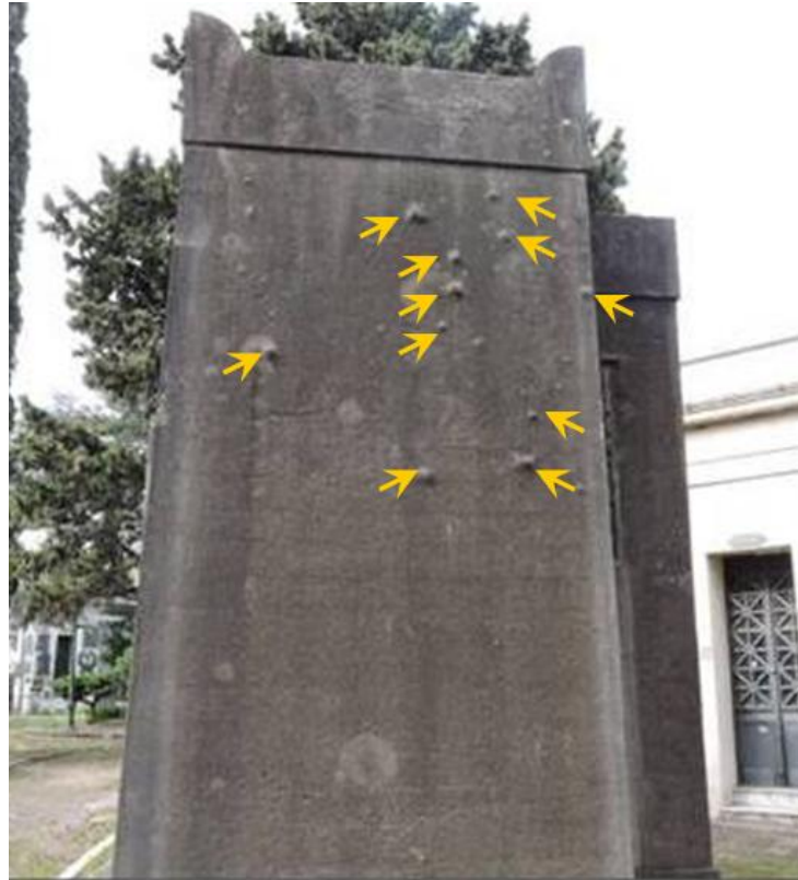
Figura 6: Pared del mausoleo colonizado con Tillandsia aëranthos (flechas amarillas)
