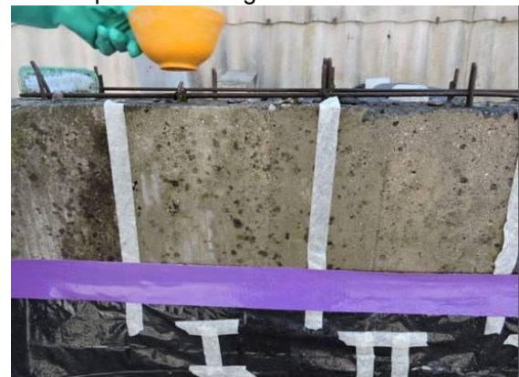
Aplicación de agua clorada al 15%
