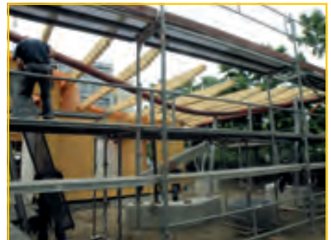
Mutige Dachkonstruktion (Foto: Sickinger)
