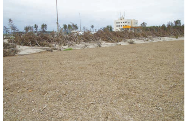
写真 24. 木製のガレキがチップ化されて、マツ林に隣接する砂浜の埋め立てに使われている (閑上).
