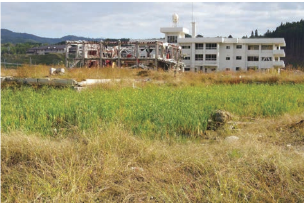
図 17. 損壊した戸倉小学校と手前のガマ群落.
