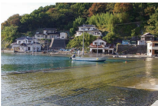
図 27. 月浦の港. ちょうど大潮であったこともあり, 地盤沈下により浸水していた.
