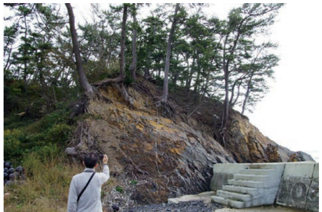
図 7. 館鼻崎突端部. 津波により土壌と植生が失わ れている.
