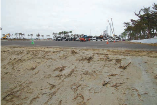
写真 17. 残存マツ林隣接地に建設されたガレキ処理場
