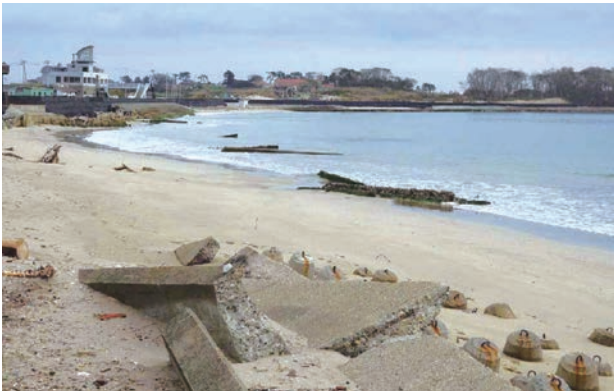
図 4. 大谷海岸. 2011 年 10 月 28 日の状況. ガレキ や枯死したマツは取り払われている. 遠方に黒く延びているのは礫を入れた袋を積 み上げた仮設の堤防.
