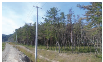
期日：2011年10月11日 場所：宮古市田老 位置：N39-43-47.7 E141-58-02.6 海拔：約4～6m 状況：残存した防潮林 内容：倒壊を免れたクロマツは約15,000本のうち約350本で葉は青々としていた。クロマツ林に隣接した神社周辺のアカマツ、スギ、カラマツの葉はいずれも赤く変色していた。
