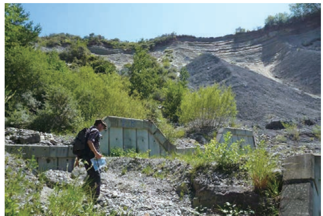
写真 1. Vercors 山地の崩壊防止対策現場。砂防ダムで浸食が食い止められた場所には Hippophae rhamnoides (白く見える) などの低木が侵入している。
