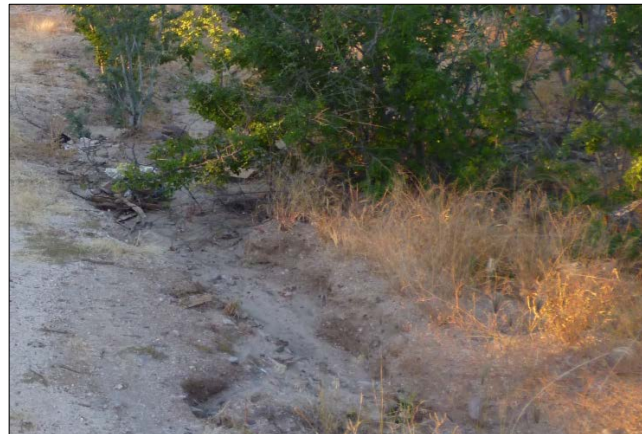
Figura V.6. Erosión hídrica presente en un camino de acceso al predio donde se construirá la subestación.
