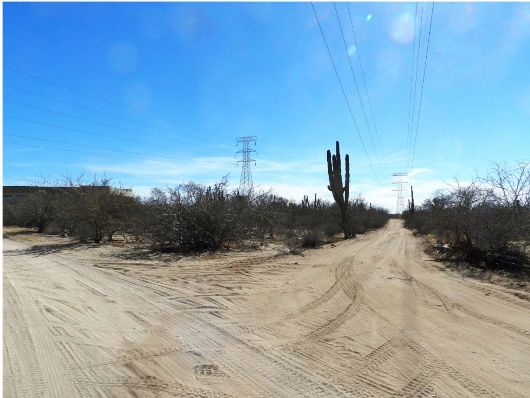
Figura II.9. Infraestructura eléctrica existente en el área aledaña al predio en que se ubicará el proyecto.
