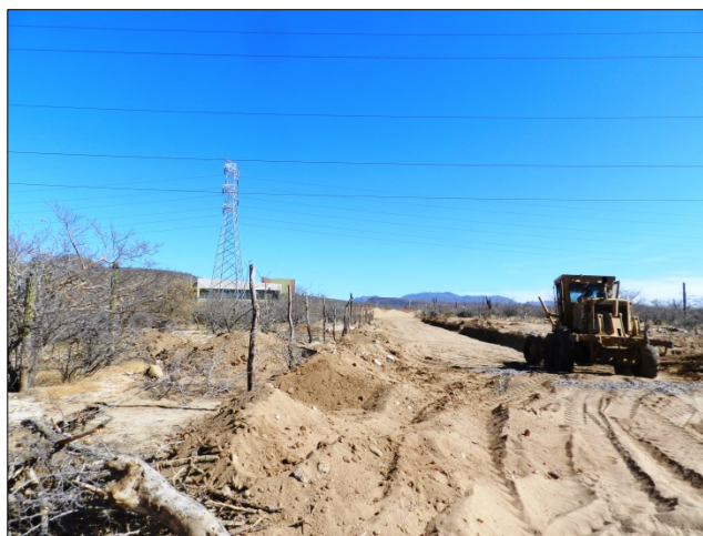
Figura XV.2. Apertura de caminos de acceso para el desarrollo urbano a 30 metros del predio de la S.E. Camino Real Bco. 1 + Mvar.
