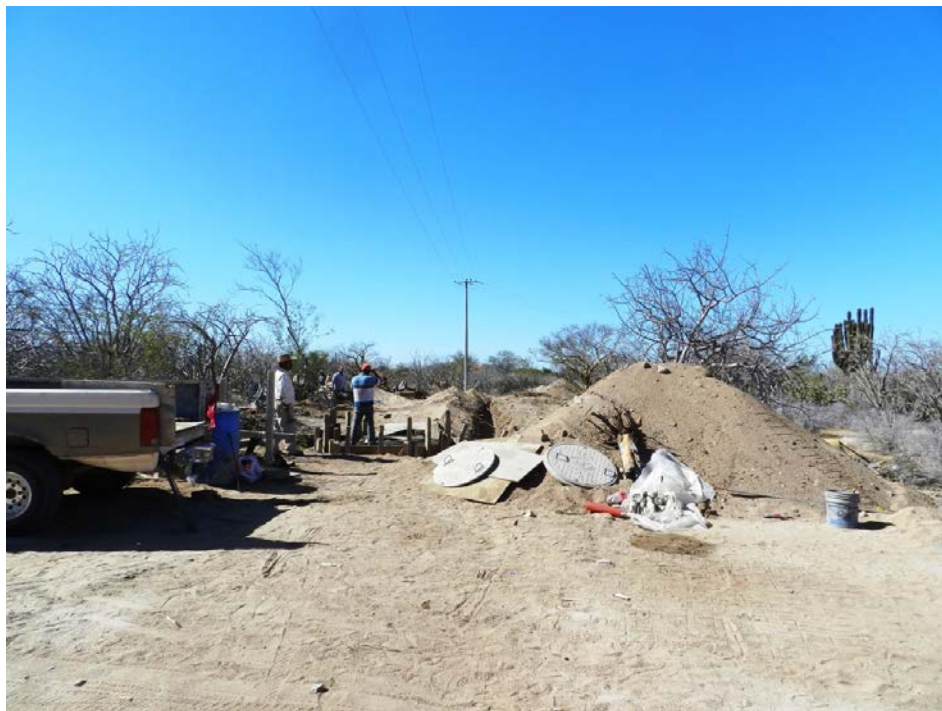
Figura II.2. Obras que se están construyendo en la zona aledaña al predio en que se ubicará el proyecto.
