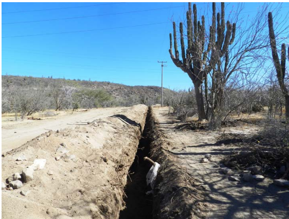
Figura II.7. Excavación para el suministro de agua potable a la Universidad Tecnológica
