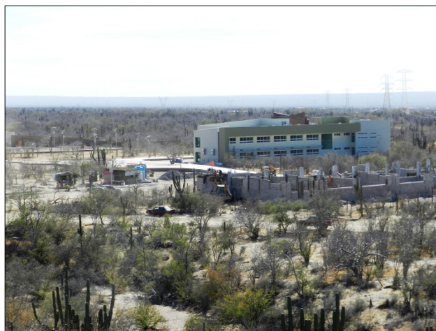
Figura XV.1. Construcción de la Universidad Tecnológica de La Paz a aproximadamente 100 m del predio de la S.E. Camino Real Bco. 1 + Mvar.
