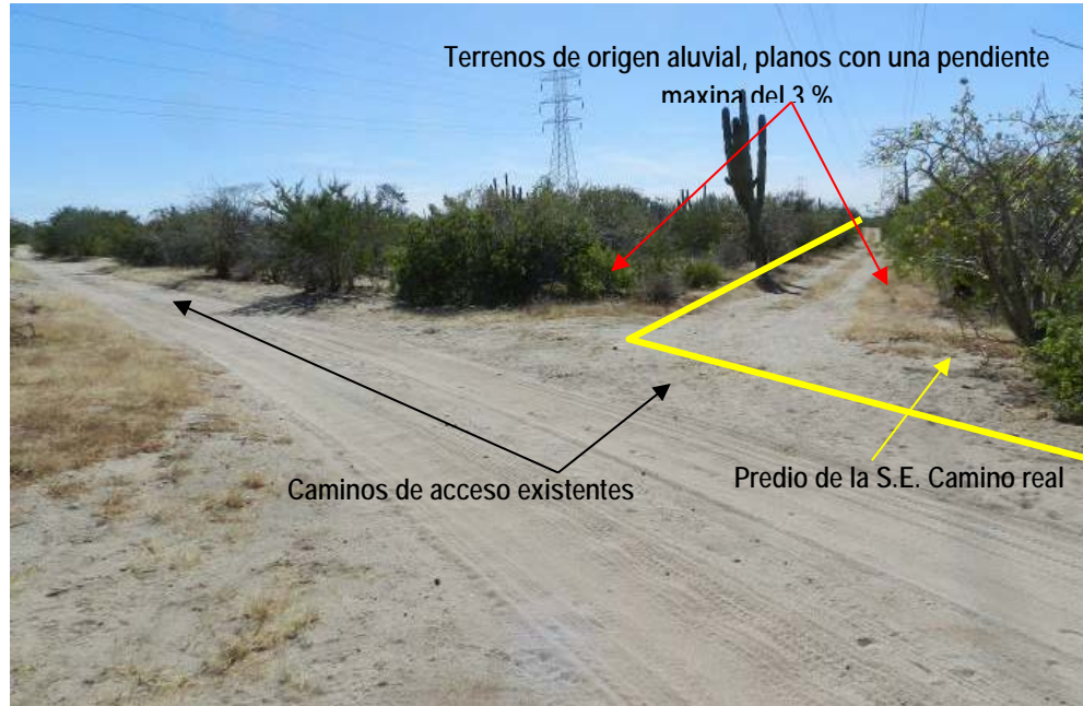
Figura VIII.3. Pendiente del terreno sobre el predio de la S.E. Camino Real Bco. 1 + Mvar y Camino de acceso de terracería le cual puede ser utilizado para el acceso a la Subestación.
