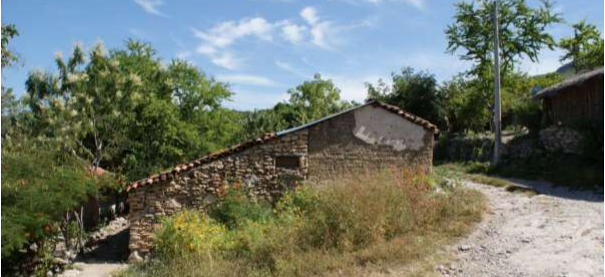
Figura II.4 Vista del tipo de materiales predominantes utilizados en las viviendas.
