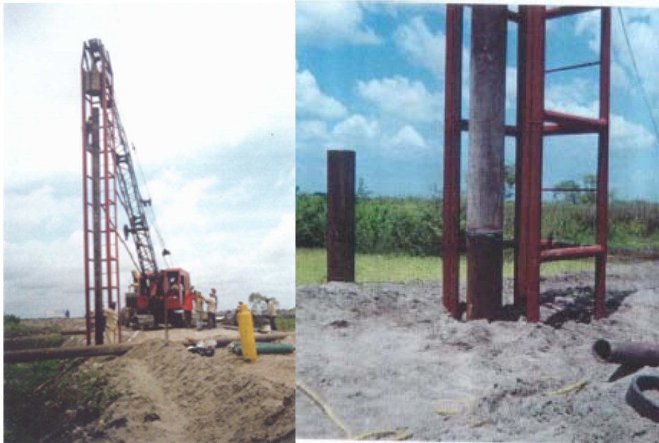
Fotografía 39. Hincado de pilotes con martillo de gravedad para la construcción de puentes “pasarela”.
