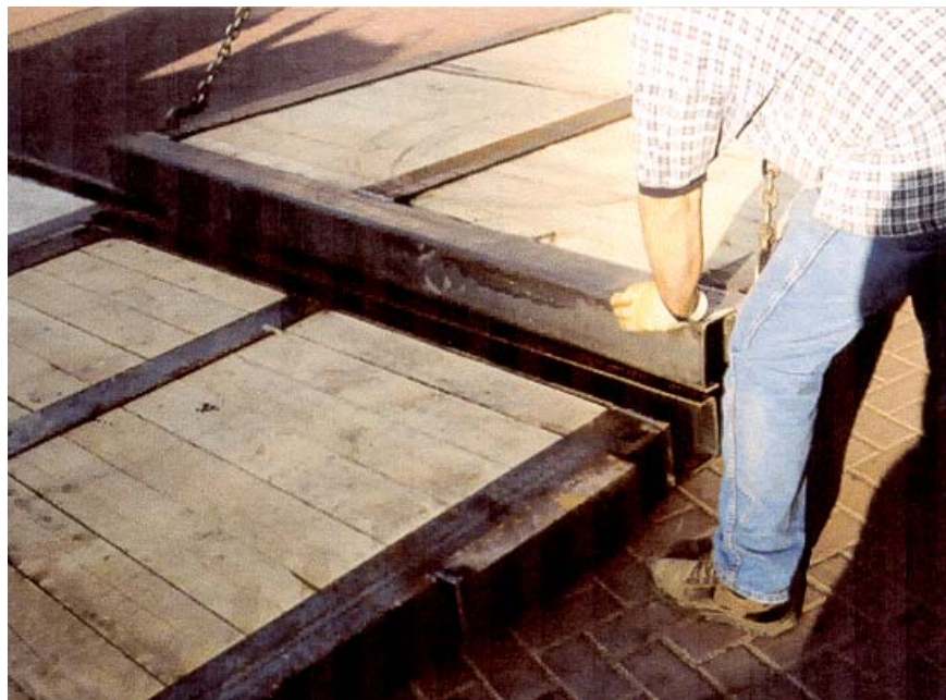
Fotografía 35. Armado de las plataformas de madera.
