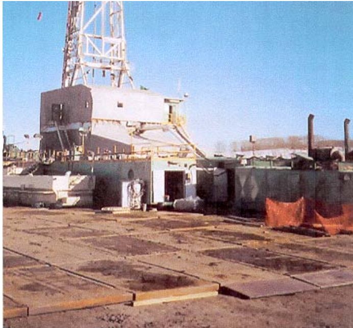
Fotografía 37. Ejemplo de utilización de las plataformas de madera en una localización de perforación.
