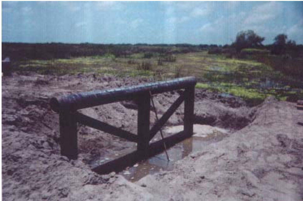
Fotografía 39. Hincado de pilotes con martillo de gravedad para la construcción de puentes “pasarela”.
