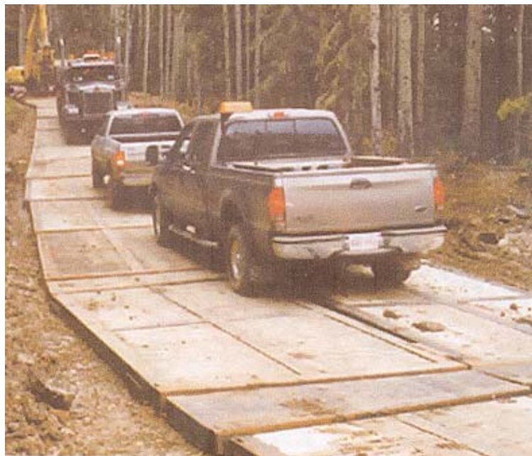
Fotografía 38. Ejemplo de utilización de las plataformas de madera en un camino.
