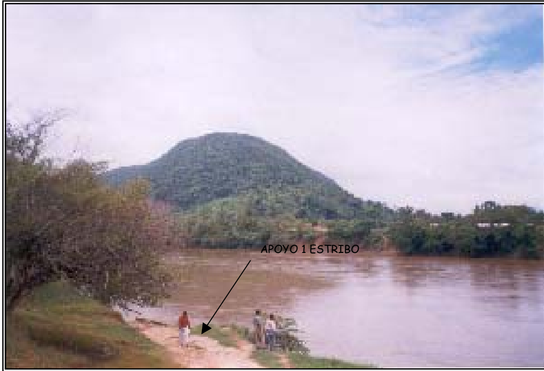
MARGEN DEL RÍO LACANTÚN- AMATITLAN, ESTRIBO APOYO 1 EPOCA DE LLUVIAS
