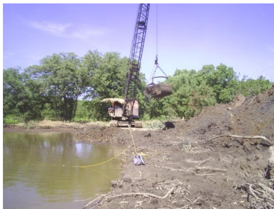
Figura 1.2 Trabajo de la draga en la rehabilitación de los canales y bordos ecológicos
