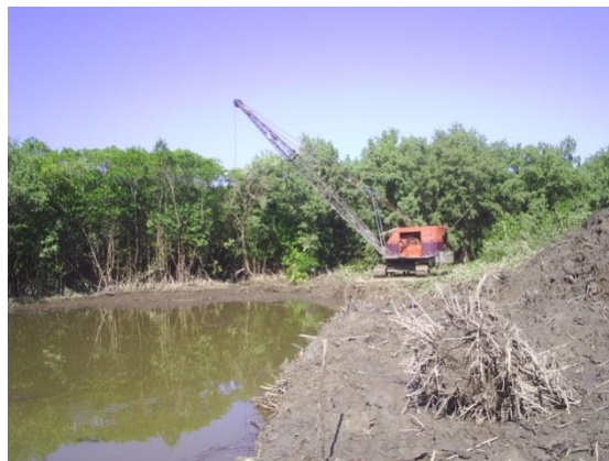
Figura 1.3 Trabajo de la draga sobre la berma de la obra
