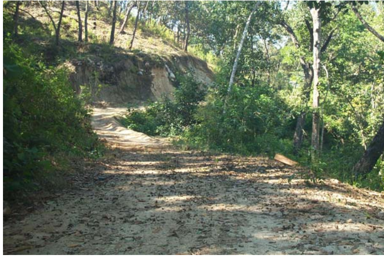
Fotografía 1. Vista del camino existente en una parte de topografía accidentada, donde será necesario realizar cortes y utilizar el material resultante para las terracerías
