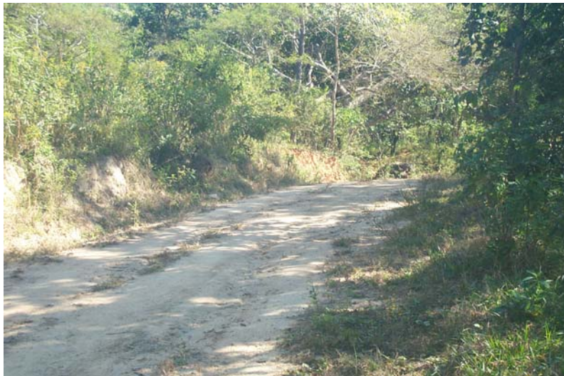
Fotografía 2. Partes del camino donde la anchura del mismo es mas grande, sin embargo se considero un promedio de tres metros de brecha existente para todo el tramo.
