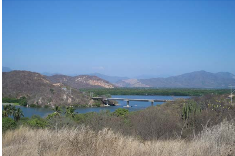
Figura IV.6. Panorámica del Puente tepalcates, sobre la laguna Cuyutlán, Municipio de Manzanillo, Colima.
