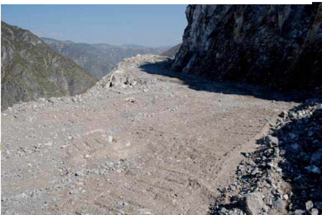
2. VISTA DEL CADENAMIENTO 1+980.64 DE DONDE SE INICIARÁ LA APERTURA Y CONSTRUCCIÓN DE LOS 3.27936 KILÓMETROS.
