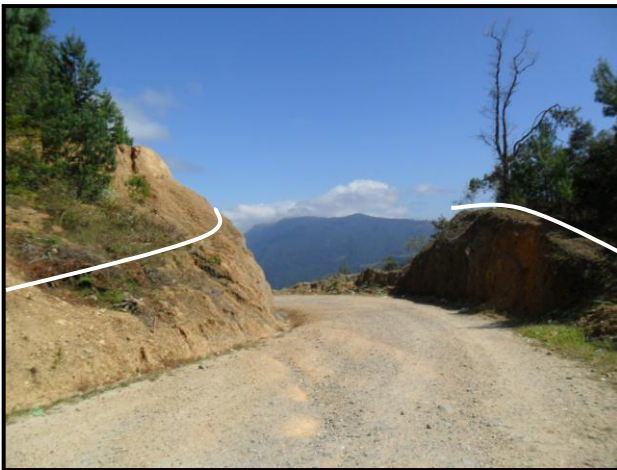
Figura 4.78. Km 4+270, corte del tramo carretero.
