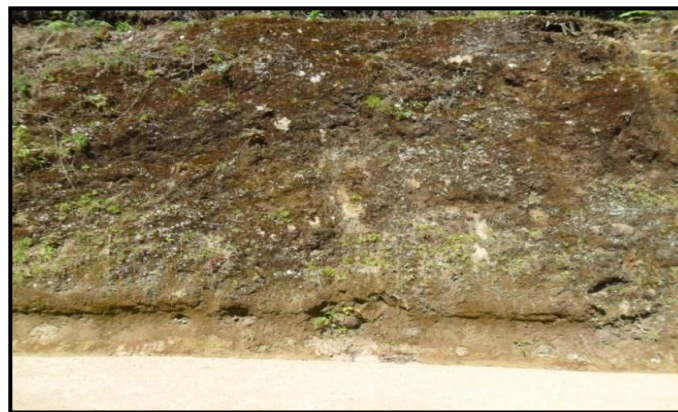
Figura 4.8. Toba acida al inicio del tramo carretero.
