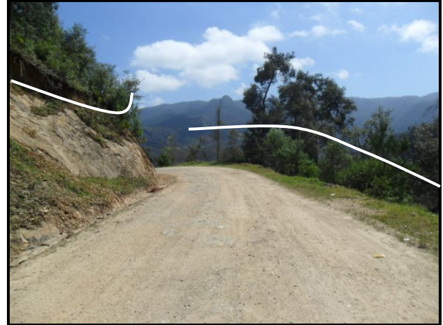
Figura 4.84. Km 5+400, elementos secundarios del BMM.
