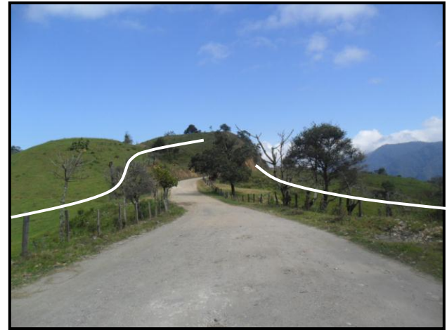
Figura 2.4. Km 7+060, zona agrícola y pecuaria del área del proyecto.
