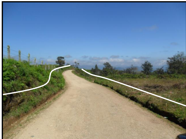
Figura 4.46. Km 1+098, zona de especies arbustivas, se observan áreas excavadas a la izquierda de la imagen.
