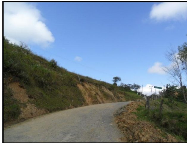
Figura 4.9. Cortes del margen carretero donde se registra la roca basáltica, zona próxima a la localidad de Coatlila.
