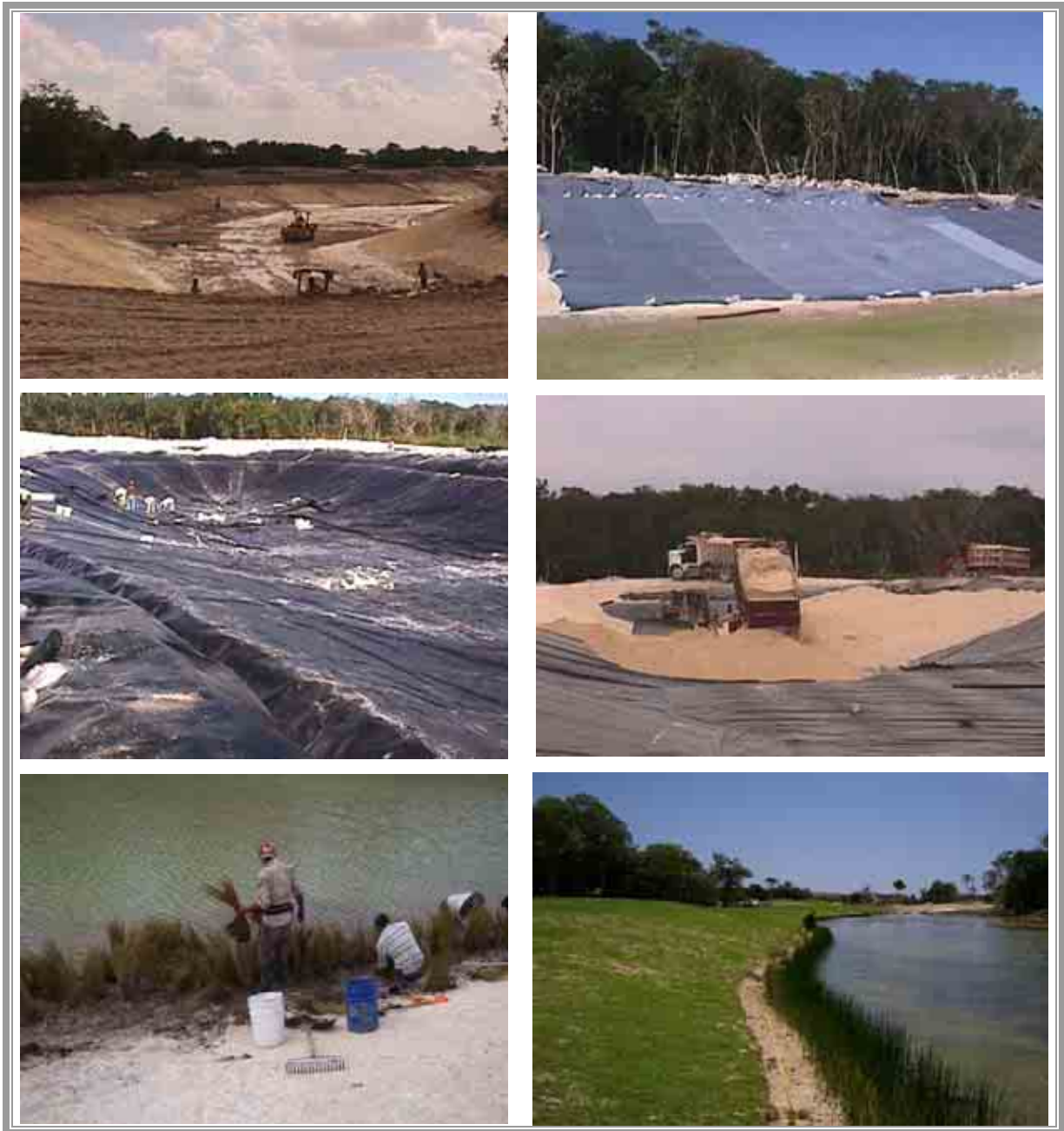
Figura 24. Proceso constructivo de un lago artificial. De arriba a abajo y de izquierda a derecha se ilustra la excavación y extracción de tierra del lago, colocación de la membrana geotextil y acabado del liner, colocación de la capa de arena para modelar el fondo, siembra de plantas de especies nativas para conformar el borde, e imagen objetivo del lago artificial.
