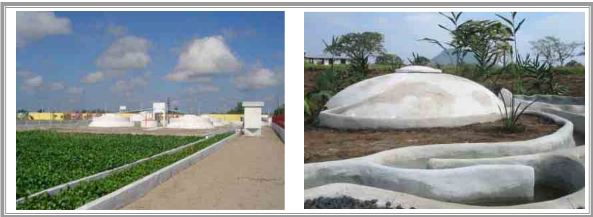
Figura 25. Planta de Tratamiento. Las imágenes corresponden a plantas de tratamiento de aguas residuales del tipo de reactores anaerobios híbridos de flujo ascendente (RAHFA), que se presentan con objeto de visualizar el aspecto de las mismas ya acabadas. Fuente: www.aitasc.com .
