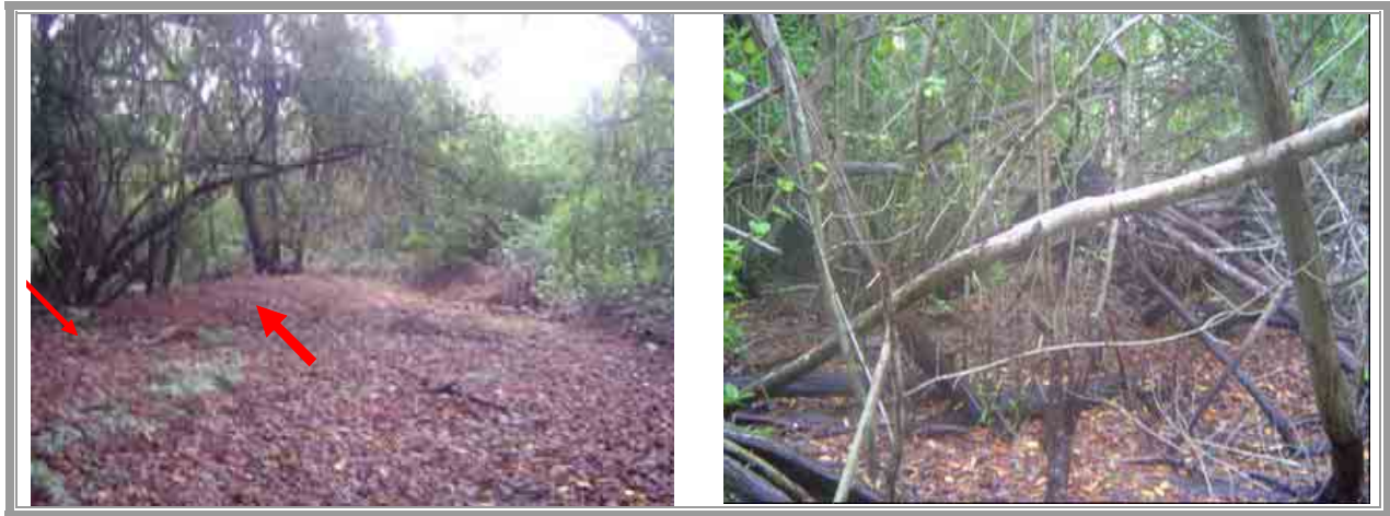
Figura 92. Obras de contención del cauce, (indicadas por las flechas) construidas en el arroyo Cajones, en su punto de contacto con la formación de un manglar (izquierda). Manglar formado en el delta del arroyo Cajones (derecha).
