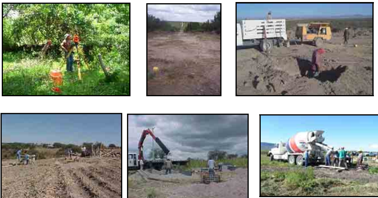
Figura II.3 Actividades de Construcción
