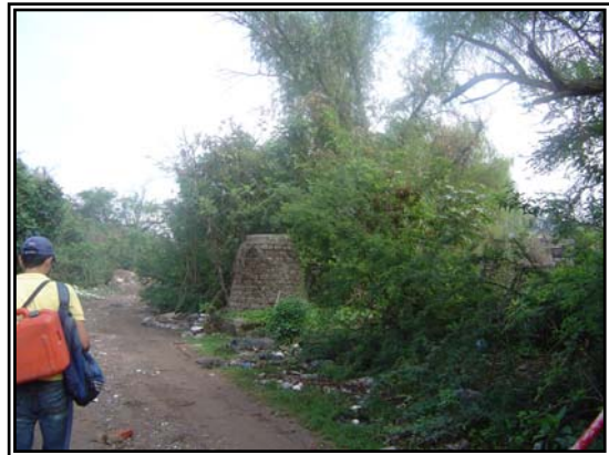
Pozo de visita en el interior del predio.
