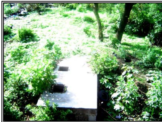
Registro de aguas residuales al interior del predio.
