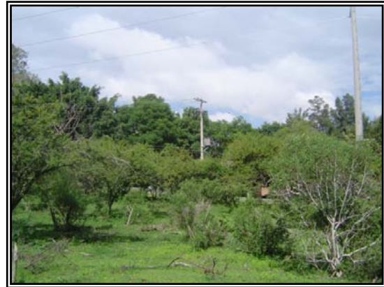
Cableado de energía eléctrica.
