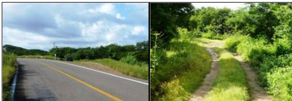
Fotografía 2.1 Brecha existente en el extremo norte de la carretera.
