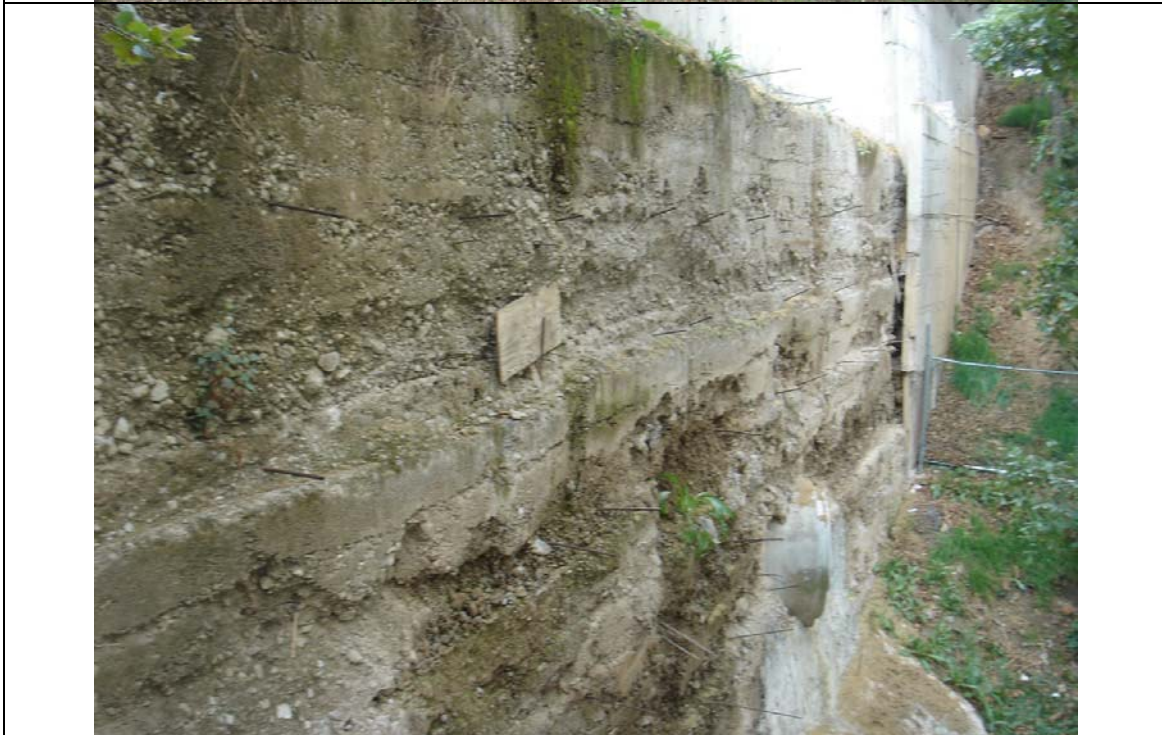
Fotografía 17 y 18. Imagen detallada del muro de contención para la estabilización y el punto de salida del encauzamiento y dirigido hacia el cauce del Río Hondo.
