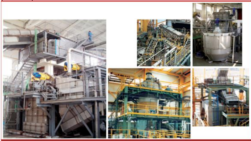
Foto 27.- Aspectos del equipo y maquinaria a emplear en la planta del proyecto.
