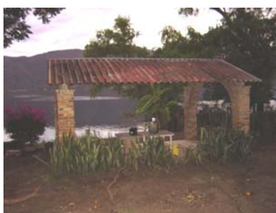
Foto 10. Esta estructura será parte de la cocina del nuevo restaurante.
