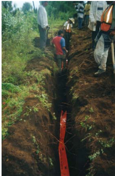
Figura No. 12.-Cinta plástica colocada como señal de advertencia
