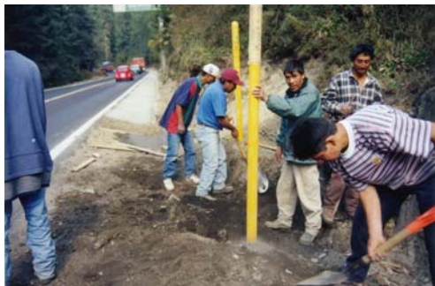
Figura No. 9.-Colocación de señalamientos
