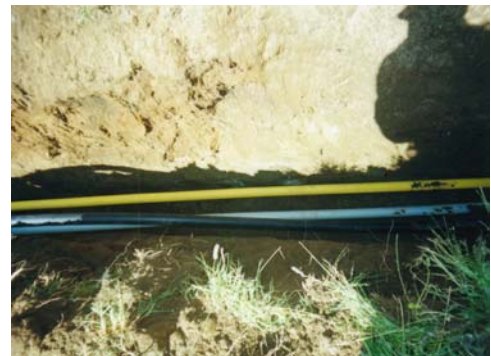
Figura No. 7.-Instalación del cable de fibra óptica
