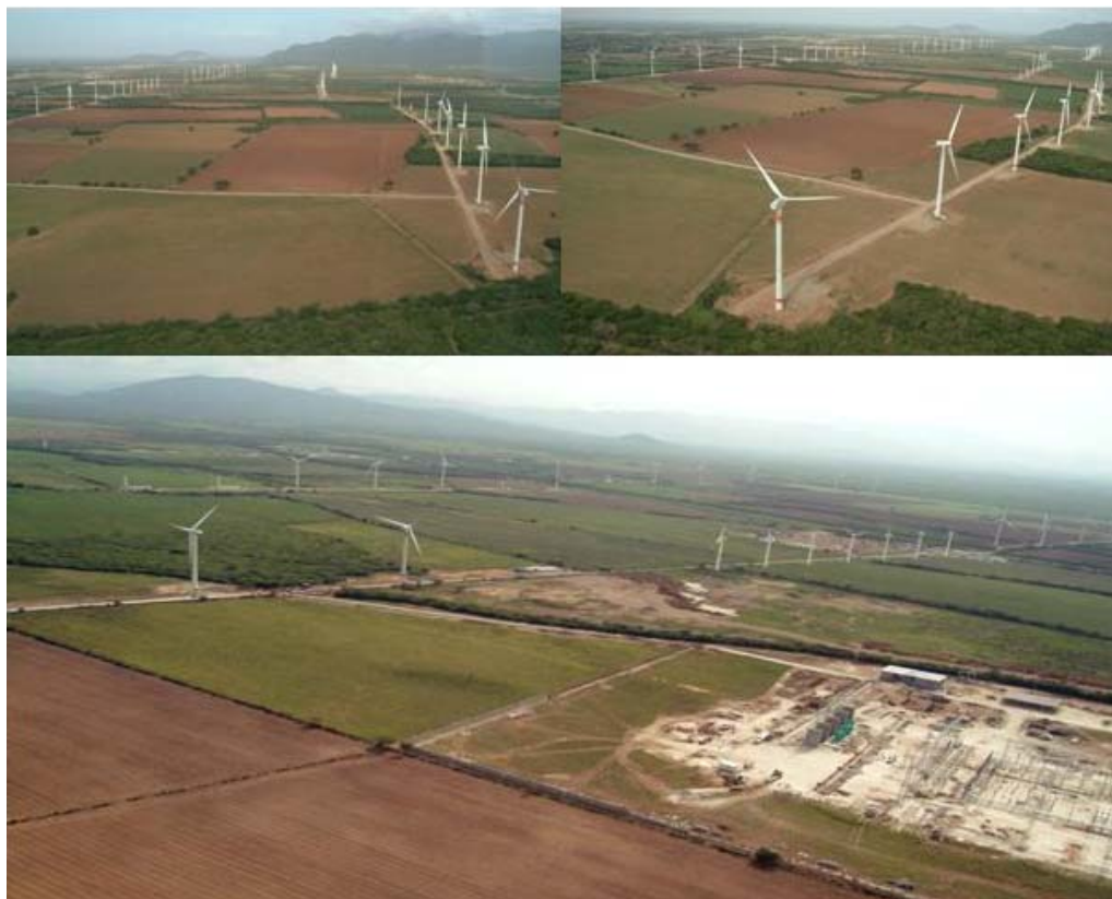
Figura 1.- Panorámicas de la distribución y arreglo de una Central Eólica, en las que se aparecian las superficies que ocupa la infraestructura y los elementos que la componen.
