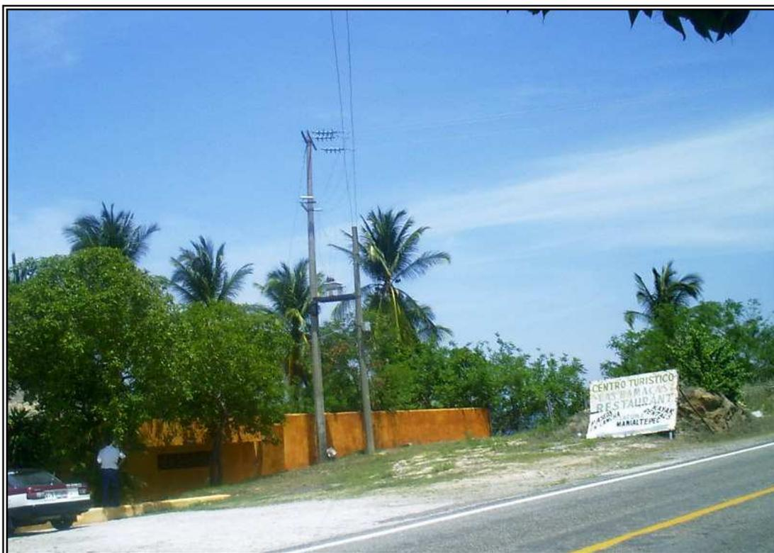
FIGURA II.1.7.5.1, PANORÁMICA QUE MUESTRA EL ACCESO A LAS INSTALACIONES DEL RESTAURANTE LAS HAMACAS, SOBRE LA CARRETERA COSTERA, SE OBSERVA TAMBIÉN LA ACOMETIDA ELÉCTRICA CON UN TRANSFORMADOR DE 50 KVA- 13200-115/220
