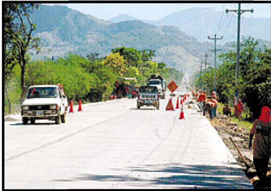
Fig. II.8 Brigada de mantenimiento a las carreteras
