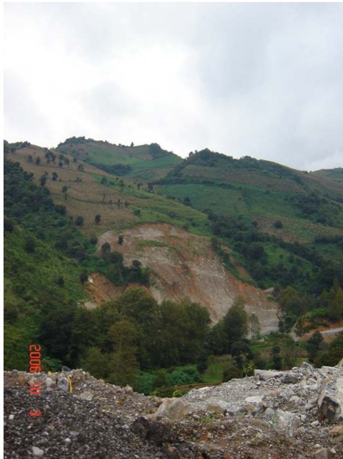
Foto VI.1.- Vista de derrumbe de material en corte muy alto de banco de extracción en la zona del proyecto.
