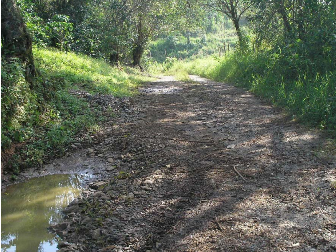
Figura II.9.- Camino de Acceso Aristeo
