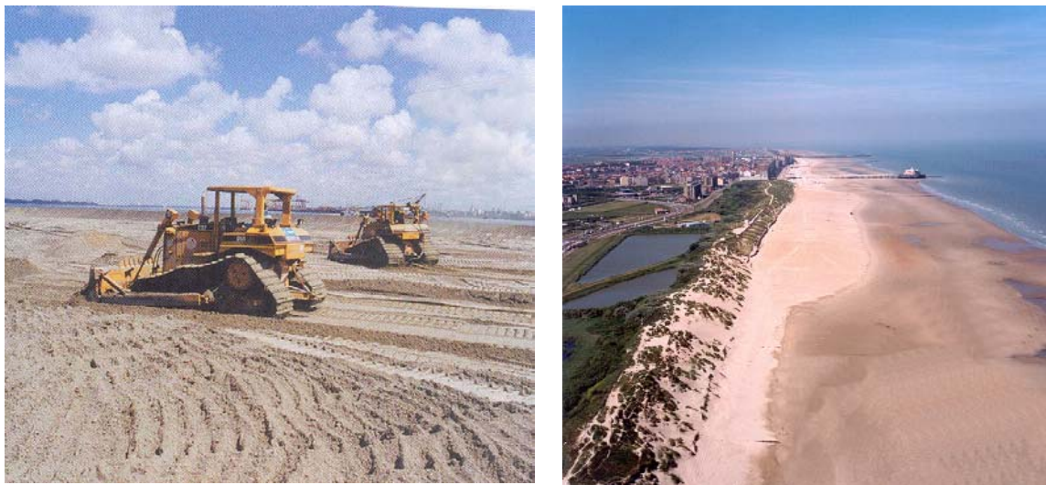
Figura II.13 Equipo terrestre y avance de obra.
