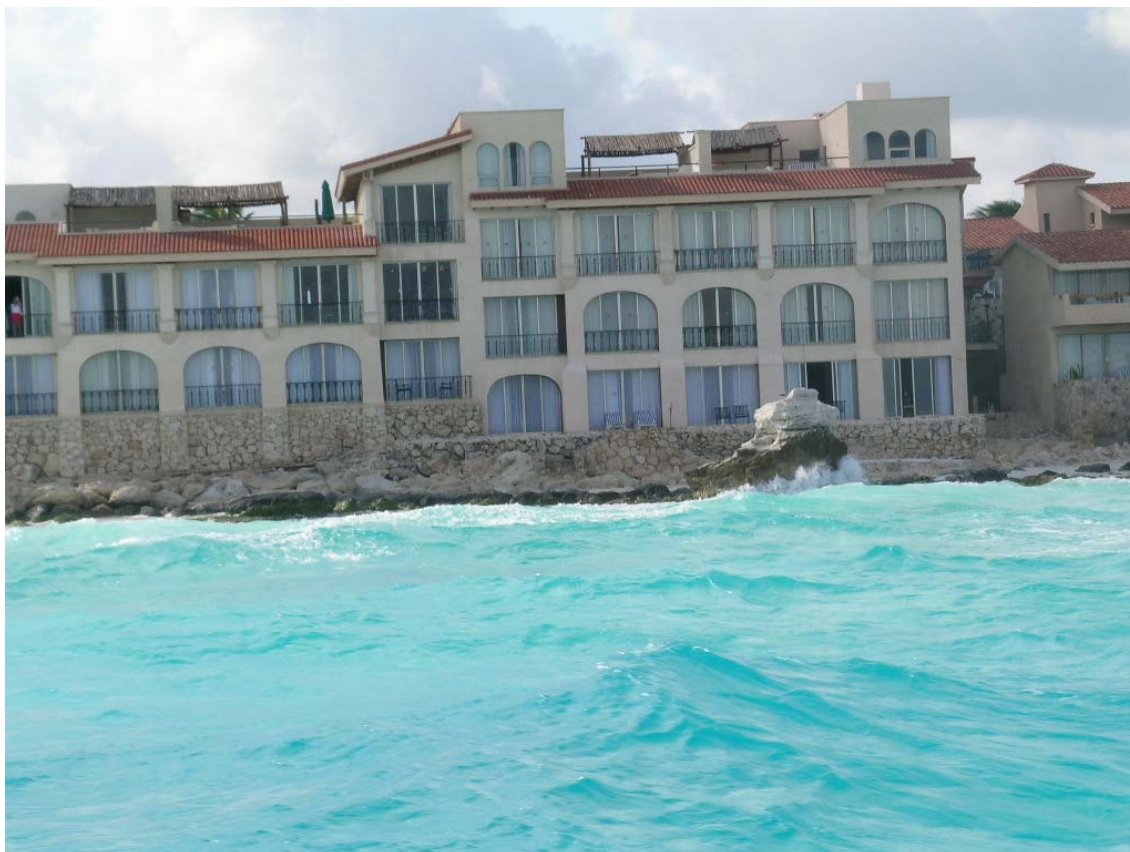
Figura IV.7 Oleaje sobre el paramento de las construcciones en sitios donde la playa ha desaparecido
