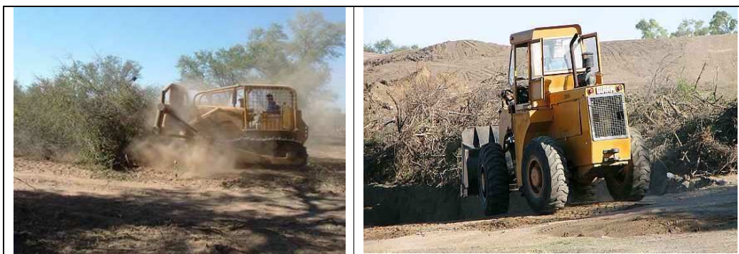
Tipo de maquinaria que puede usarse en la actividad de desmonte
