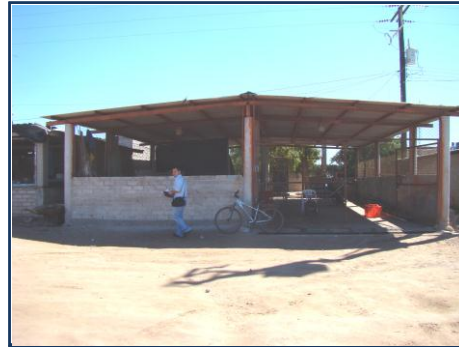
Vista Frontal del Cobertizo de las Instalaciones y su patio de Acceso a Dársena
