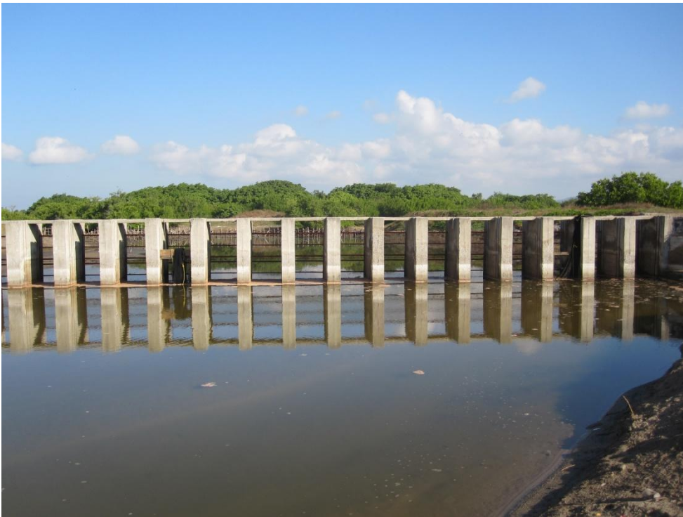
Fig. No. 2 Boca del estero y estructura de control hidráulico.
