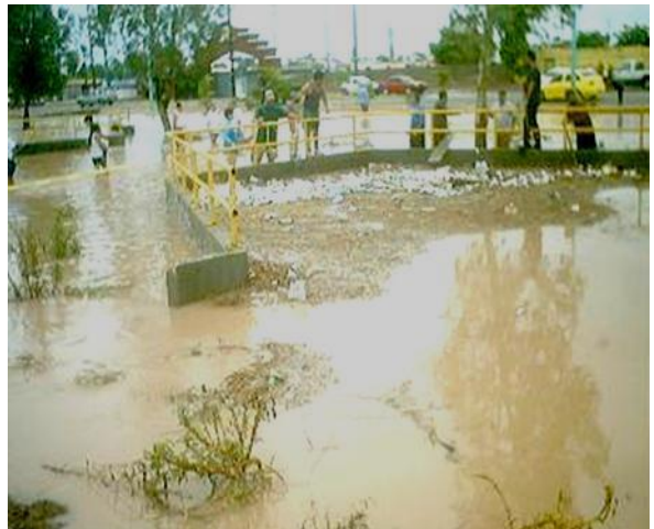
Fotografía 2 y 3.- Inundación de un sector de la ciudad de Los Mochis por agua pluvial acarreada por el dren Juárez el cual se desborda debido a las intensas precipitaciones captadas por mas de 63,000,000 m 2 de terrenos agrícolas que se localizan en las periferias al norte de la Ciudad de Los Mochis.
